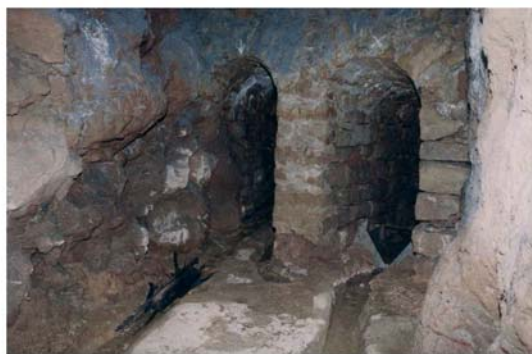
Galerie souterraine chemin des Gorgerates
