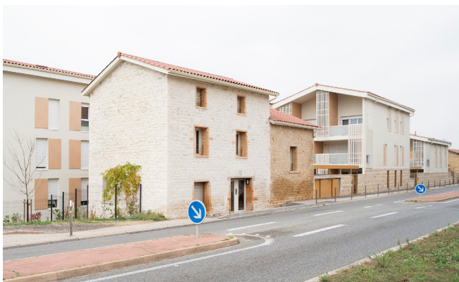
▲ Réhabilitation d'habitat rural et construction de logement collectif, Lissieux (69), Silvère Weiss Séméio Architecture ©
